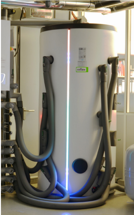
Abbildung 7: Ein Warmwasserspeicher – hier ein Exemplar aus einem Testlabor am DLR-Institut für Vernetzte Energiesysteme – dient als Ergänzung einer Kraft-Wärme-Kopplungs-Anlage zur Pufferung anfallender Wärme.
