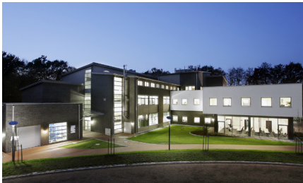
Abbildung 20: In der für Erdgas ausgelegten Bestandsbebauung – wie hier in einem Institutsgebäude des DLR – ist ein Betrieb mit reinem Wasserstoff ohne technische Anpassungen nicht möglich.
